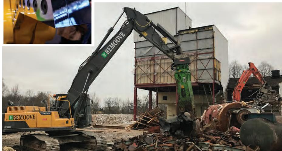
Per il settore "Recycling" Trevi Benne amplia la serie **MARILYN CS** aggiungendo il modello **CS 180RS**: un vero e proprio colosso con un peso di 18.500 kg., un'altezza di quasi 6 metri, un'apertura di 1.100 mm. che sprigiona alle lame una forza superiore a 1.500 ton.
